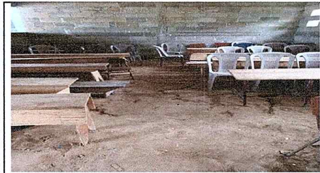
Foto 3: Colocacion de pisos.
